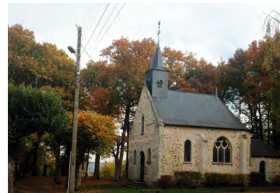
Réseau électrique à Jeufosse
