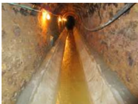
Réalisation du radier d'un ovoïde
