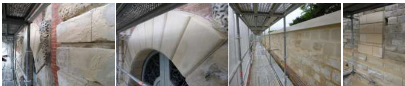
Demain phase IV : commencement des travaux mi 2015
