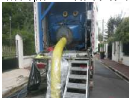
Gainage d'un collecteur
