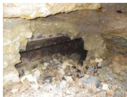
Remplacement d'une partie du collecteur
