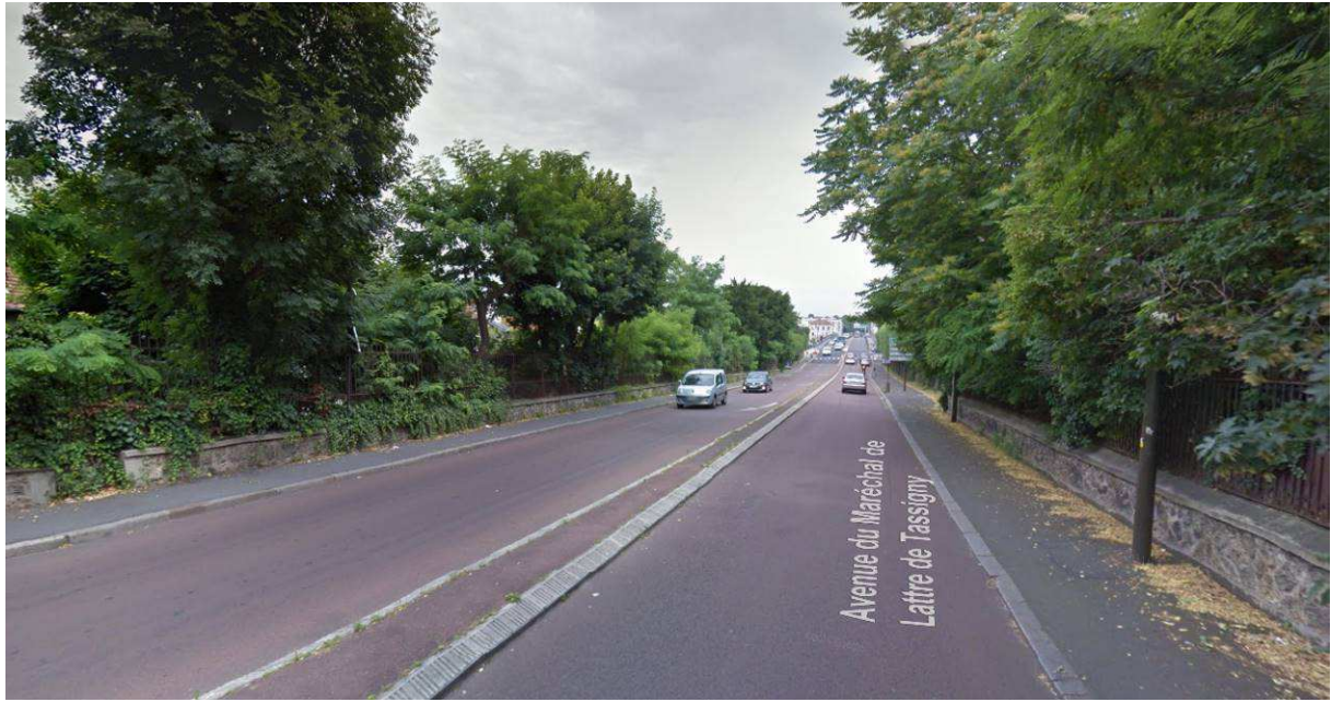
Fin du tronçon de RD190 vers le Pont du Pecq
