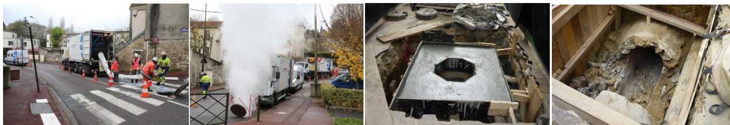
Chantier rue des Lavandières
