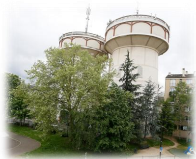
Châteaux d'eau Desoyer
