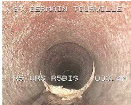
Exemple : Inspection télévisée dans le réseau d'assainissement - Rue de Tourville - 2017
