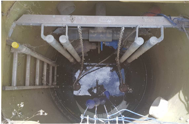
Exemple : poste de refoulement du nouveau cimetière - 2017
