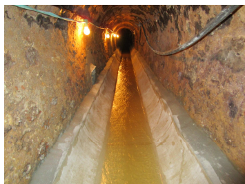
Exemple : Réhabilitation d'un collecteur visitable par mise en place de coque pour restructuration du radier – Rue d'Ayen - 2014
