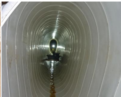
Gainage d'un réseau de type ovoïde (avant / après)
