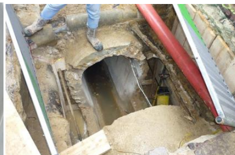
Création d'un regard de visite
