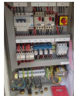
Exemple : Armoire électrique du poste Winchester
