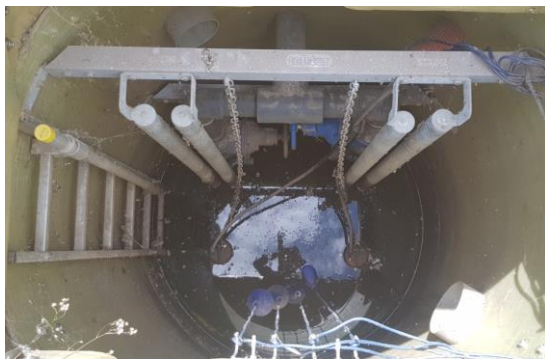
Exemple : poste de refoulement du nouveau cimetière
