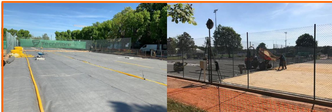
Pendant la rénovation
