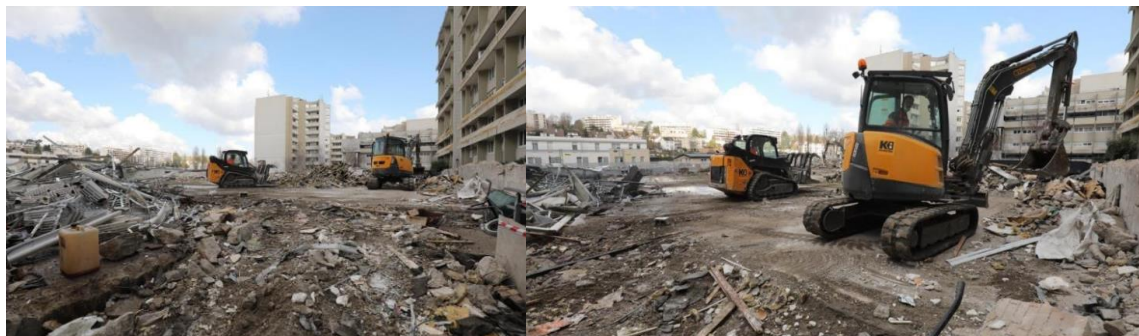
Travaux de démolition de l'école maternelle Frontenac
