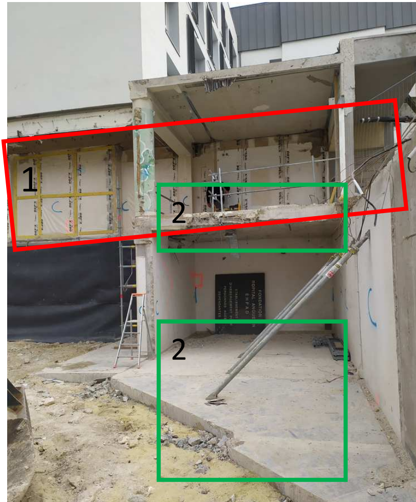
Photo B : Vue partielle de la façade du sous-sol et rez-de-chaussée
