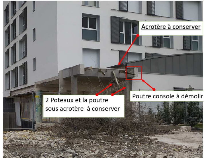
Photo A : acrotère existant au PH RDC à conserver
