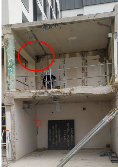
Photo B : Poutre existante au RDC
