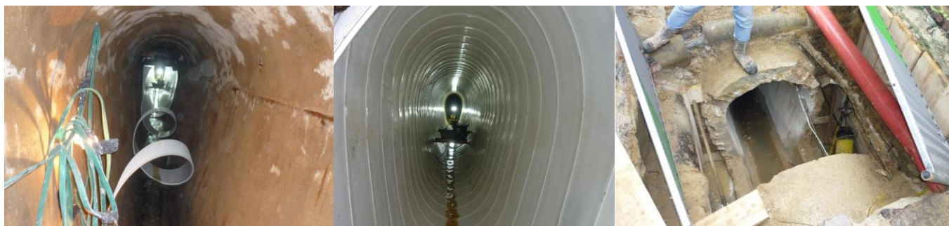
Gainage d'un réseau de type ovoïde (avant / après)
