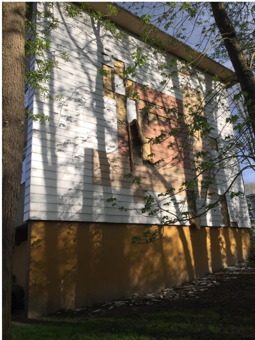
F - BÂTI VIEILLISSANT DANS L'EMPRISE DU VILLAGE HENNEMONT (SOURCE TRANS-FAIRE, 2018)
