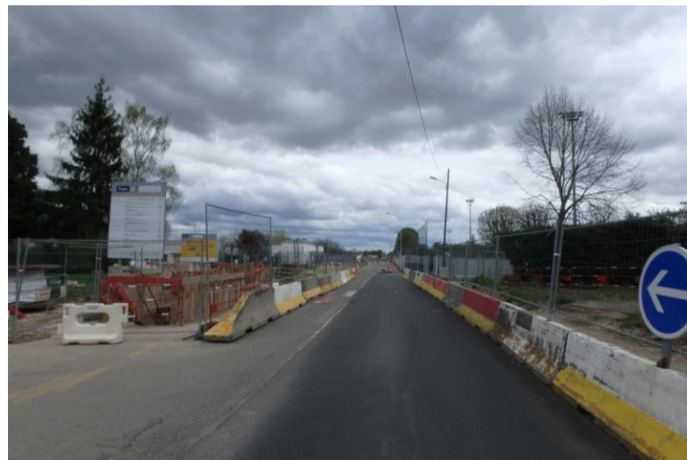
B - TRAVAUX LE LONG DE L'AVENUE KENNEDY, PRÉPARATION DE L'ARRIVÉE DU TRAM 13 (SOURCE TRANS-FAIRE, 2018)
