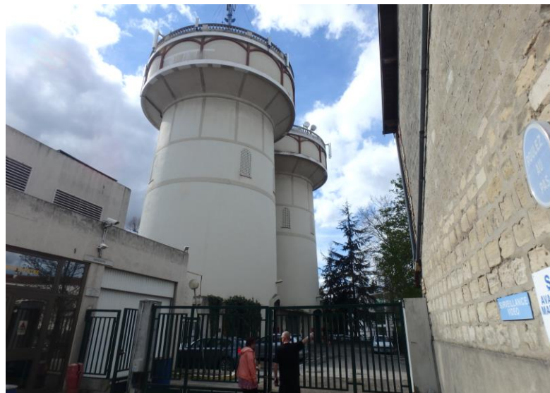
C - CHÂTEAUX D'EAU (SOURCE TRANS-FAIRE, 2018)
