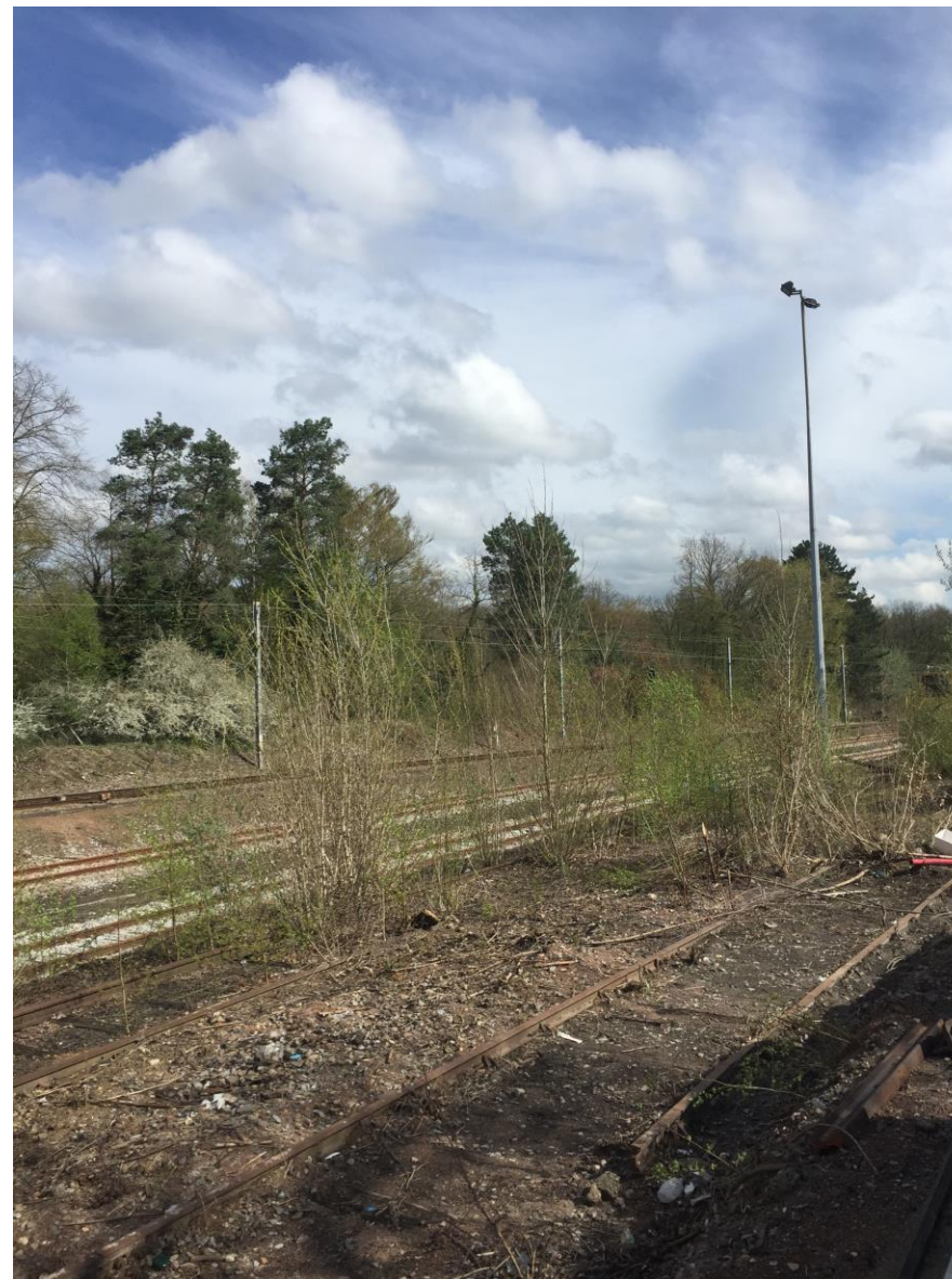
C - FRICHE FERROVIAIRE (SOURCE TRANS-FAIRE, 2018)
